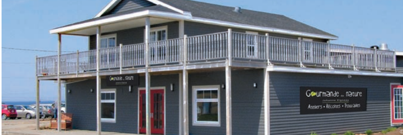
▲ Un édifice réaménagé qui comportera une boutique, un atelier culinaire et une cuisine de production.
