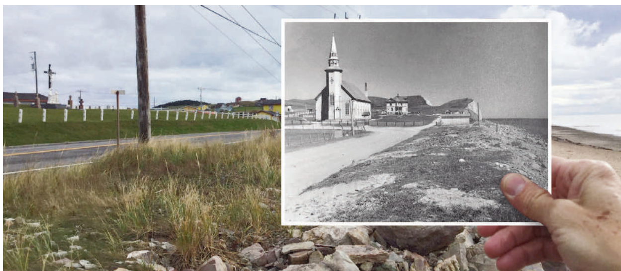
▲ L'église de Havre-aux-Maisons, construite en 1898.
