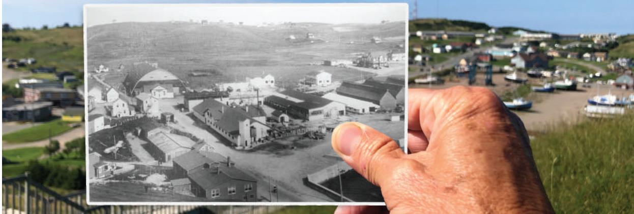
▲ L'ancienne aréna de Cap-aux-Meules qui se dresse face à la rue qui conduit sur le quai. Coll. Musée de la Mer.
